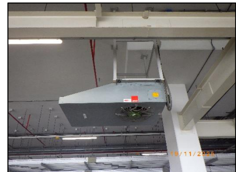
รูปที่ 2-15 พัฒนผลักอากาศ (พัดลมครูเกอร์) บริเวณที่จอดรถ
