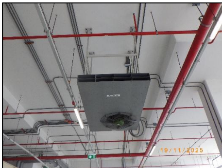
รูปที่ 2-15 พัฒนผลักอากาศ (พัดลมครูเกอร์) บริเวณที่จอดรถ
