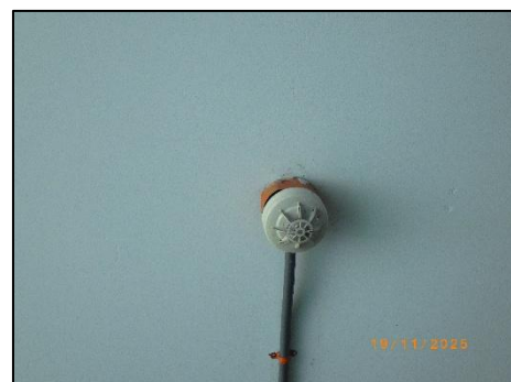
รูปที่ 2-57 เครื่องตรวจจับความร้อน
