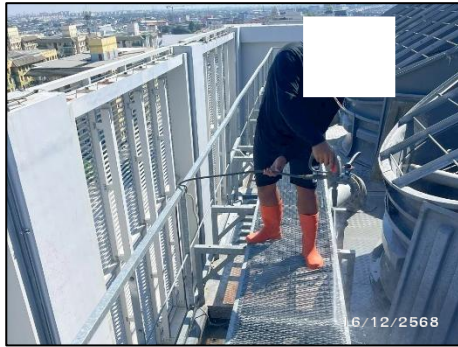
รูปที่ 2-53 การทำความสะอาดหอดึงเย็น
