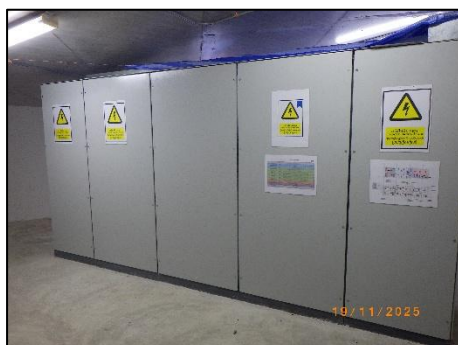
รูปที่ 2-27 มิเตอร์ไฟฟ้าระบบบำบัดน้ำเสีย
