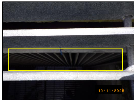
รูปที่ 2-33 ตะแกรงดักมูลฝอยที่บ่อบำบัดน้ำเสีย ก่อนระบายออก
