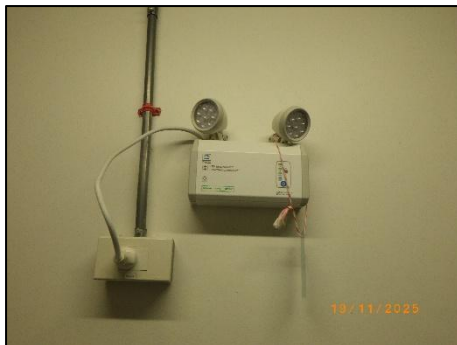
รูปที่ 2-70 ไฟฟ้าส่องสว่างฉุกเฉินและหลอดไฟ บริเวณบันไดหนีไฟ
