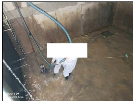
รูปที่ 2-81 การทำความสะอาดถึงเก็บน้ำใช้
