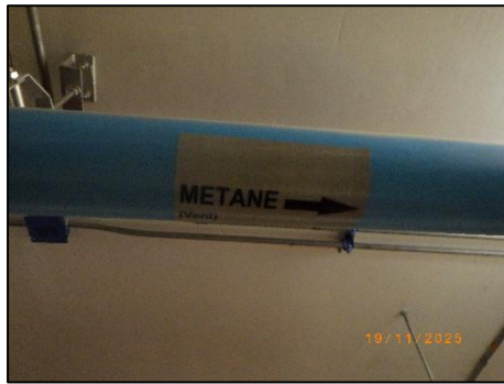
รูปที่ 2-25 ท่อระบายก๊าซมีเทนไปบำบัดโดยวิธี Biological Oxidation
