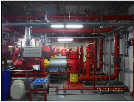
รูปที่ 2-60 เครื่องสูบน้ำดับเพลิง
